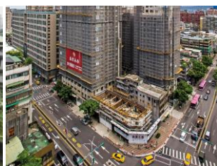
圖 5 接近完工建物 4
