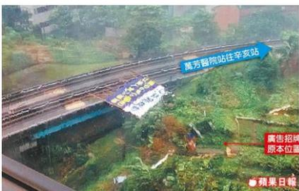
巨幅廣告傾倒侵入台北捷運軌道意外，影響 2000 名旅客通勤，還害列車撞上造成車體刮傷。北市廣告物管理機關建管處 104 年 6 月 13 日表示，廣告物申設規定並未規範捷運周邊或沿線設置廣告物，基於公共運輸安全，建管處與北捷將會商研議做適度限制。
