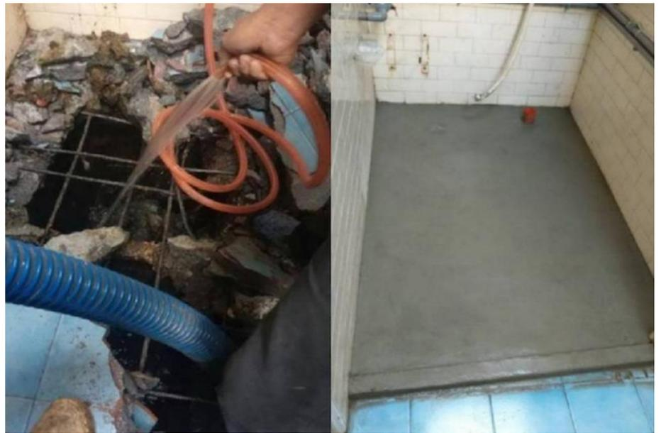
高市工務局推動免費廢除化糞池化專案，圖為糞池廢除施工中(左)與化糞池廢除完工後(右)對比。(圖 / 高雄市政府工務局提供)
