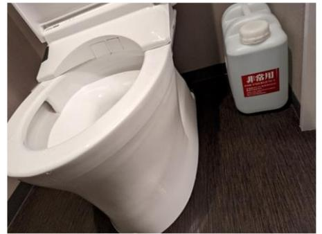
圖 5 座式馬桶旁放置緊急時廁所洗淨用水
