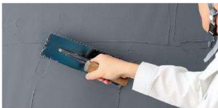
照片 4 有機類接著劑的抹平
