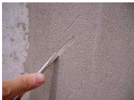
照片 1 檢查基底的硬化狀態
