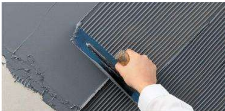
照片 3 有機類接著劑抹上後的刮取梳痕
