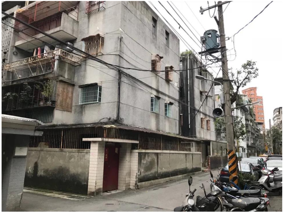
危老 8%時程獎勵 5 月 11 日截止，現已湧現一波趕搭 8%獎勵末班車的熱潮。圖為新北市新店區寶強段危老重建基地。圖 / 新北都更處提供
