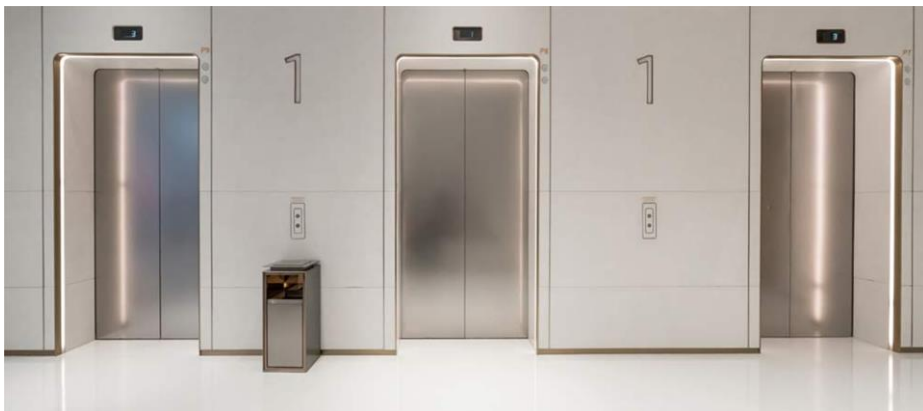
對於老舊公寓帶給老年人口行動不便與困擾時，加裝電梯確實可以立即得到改善，並延長原建築使用壽命。圖 / freepik
