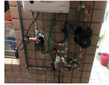
圖 9:加壓設備改善後照片
