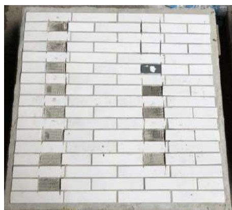
圖 2 拉拔試驗完成之牆面照 (結構體灑水)
