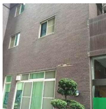
圖 10 台南某大樓磁磚剝落
