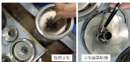
圖 13 檢視循環水泵內部狀態 (已更新替換)
