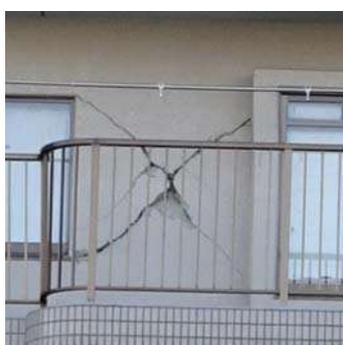
圖 8 外陽台非結構材損傷
