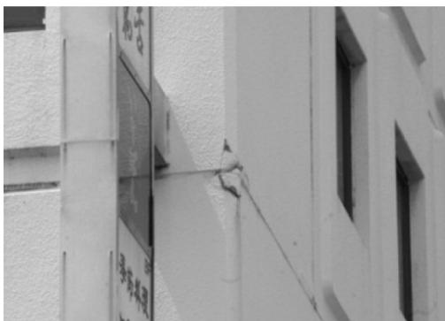
圖 2 混凝土外牆脫落(參考來源: Sasaki Tetsuya 等, 2012)
