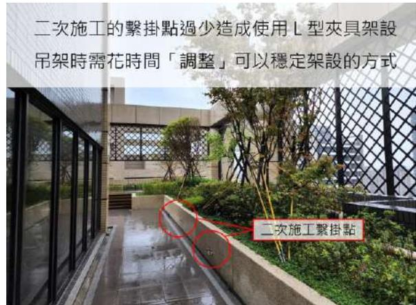
圖 17 使用夾具耗時案例圖說
