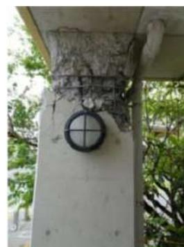
圖 5 柱頭主筋挫曲破壞(參考來源: 國土交通省, 2016)
