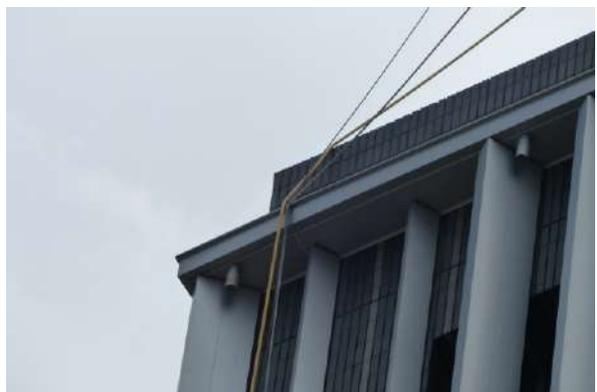
圖 18 立面縫隙勾住吊籠線路
