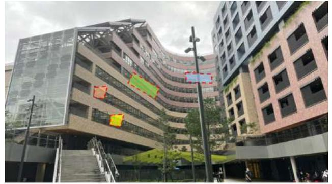
圖 17 明倫社宅廊道外推「跳層」示意圖
