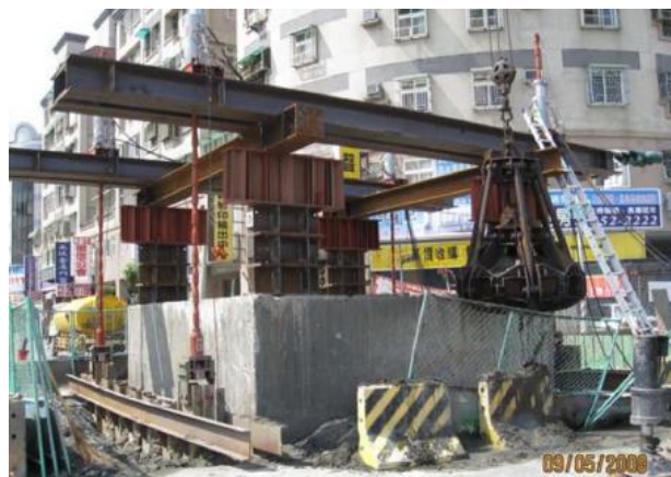
圖 3. 壓入式 RC 沉箱施工
