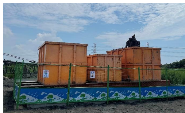
圖 2. 自重力沉箱搭配配重塊下沉
