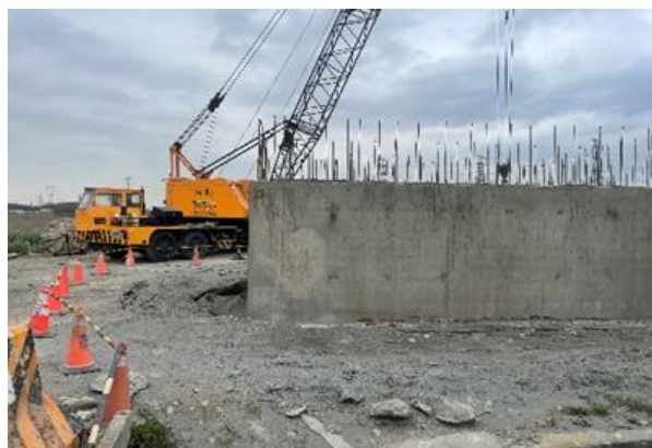
圖 1. 自重力沉箱開挖下沉施工
