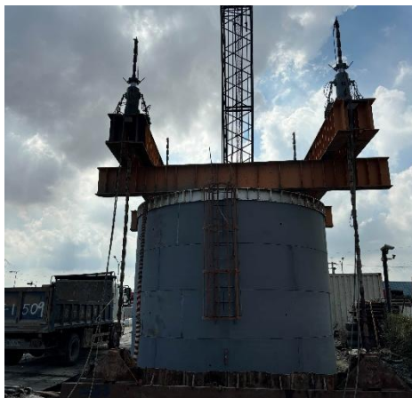
圖 4. 壓入式鋼製沉箱施工
